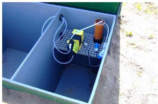
Figur 3 Anlægget i Silkeborg. I venstre side af venstre billede ses låget af tanken fra hvilken aluminium doseres til anlægget. På højre billede ses tanken med doseringspumpe og plads til palletank for aluminiumssalt (tv).
